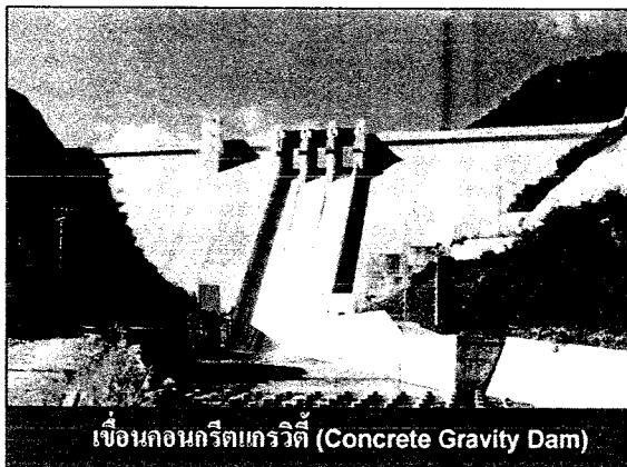
ເຊື່ອນກອນກ්‍රීතແກຣවິຕ් (Concrete Gravity Dam)
