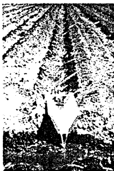
ฝายวัดน้ำขนาดเล็กติดตั้งที่ท้ายแปลงของพื้นที่เพาะปลูกที่ใช้ระบบการให้น้ำแบบร่องคู เพื่อวัดปริมาณน้ำที่ไหลทั้งไปทางด้านท้ายแปลง
