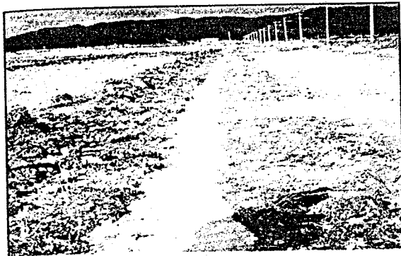
การกลบร่องหลังจากการวางท่อระบายน้ำใต้ดิน
