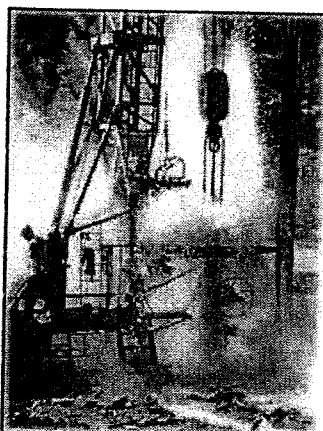
เครื่องมือที่ใช้ สำหรับขุดเจาะ บ่อน้ำใต้ดิน
