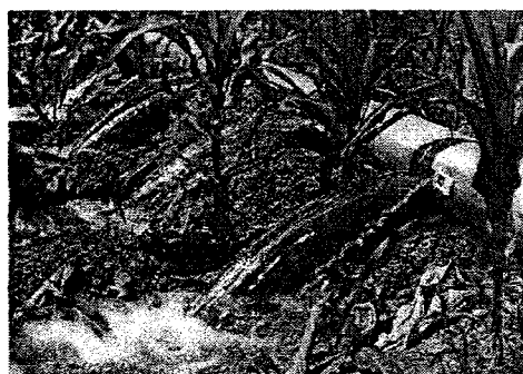
ท่อส่งน้ำพร้อมประตูน้ำในระบบการให้น้ำแบบร่องคู
